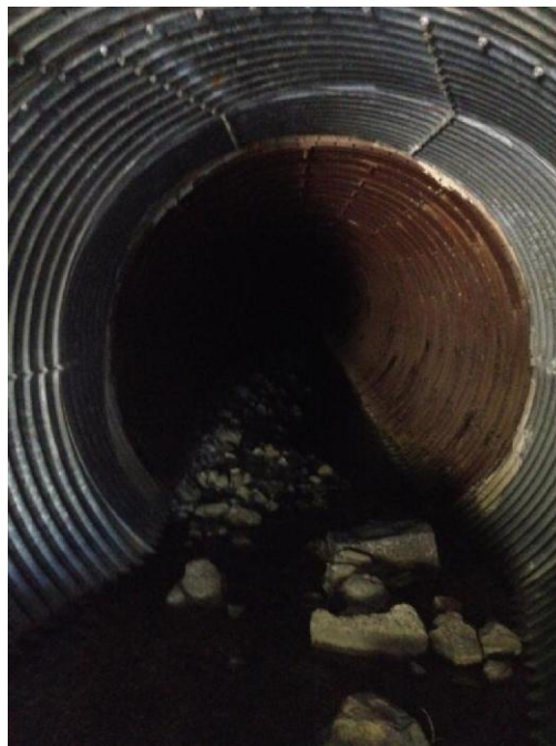
Figure 3.2 Transition de TTO à tôle de revêtement – Juillet 2012
